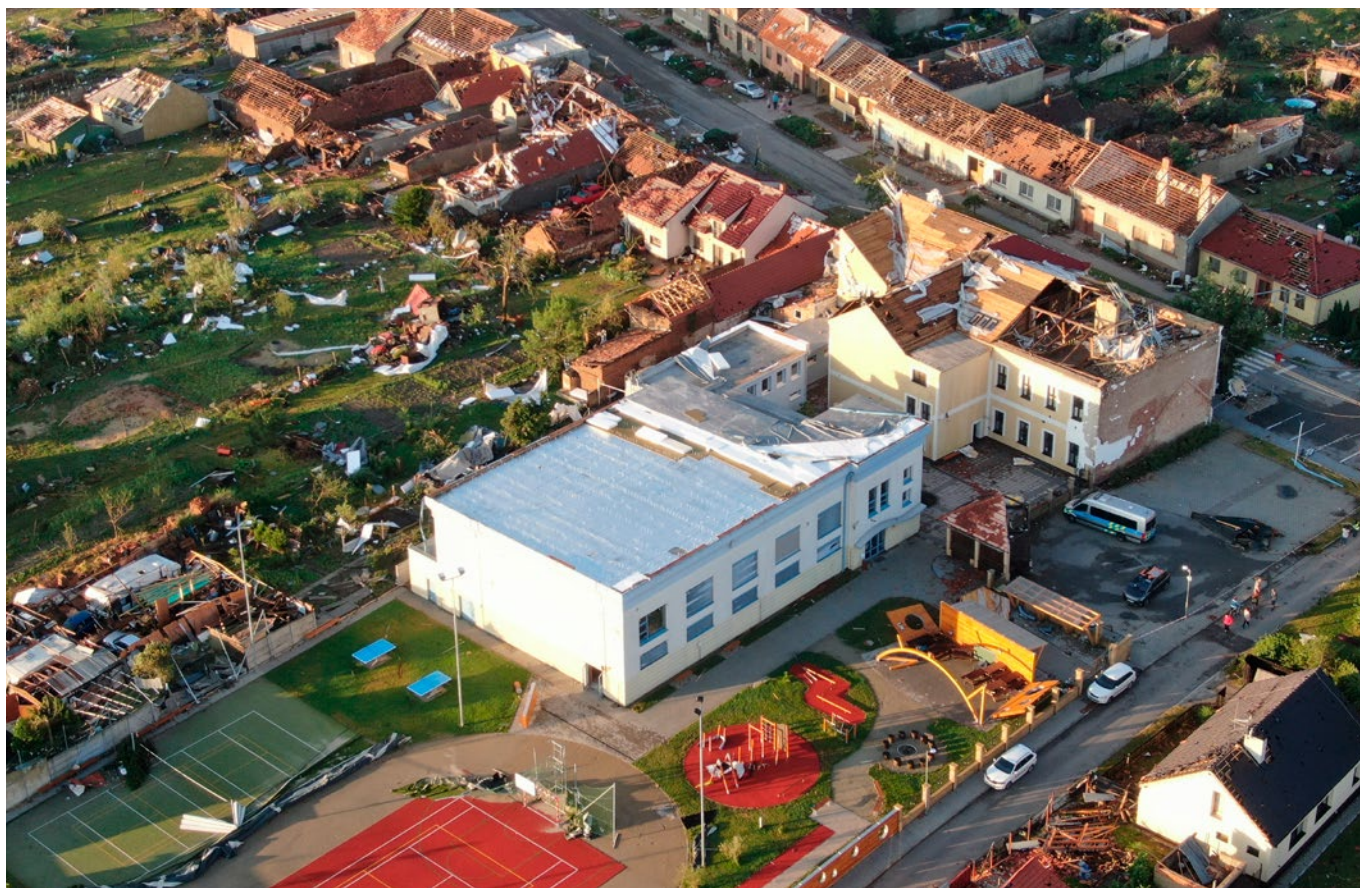
Stav školní budovy v Hruškách po tornádu v červnu 2021
